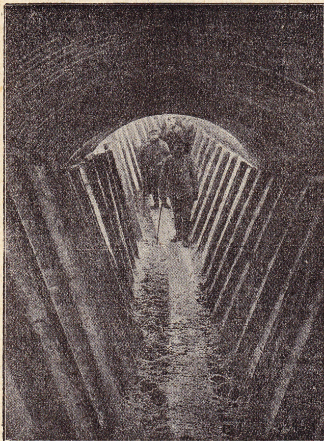
Une tranchée-tunnel conduisant à la ligne de feu.
